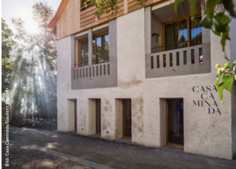
Die Casa Caminada ist aus zwei alten Ställen entstanden.
